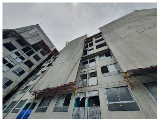
ภาพที่ 2.2-14 ผนังชนิดสำเร็จรูป
