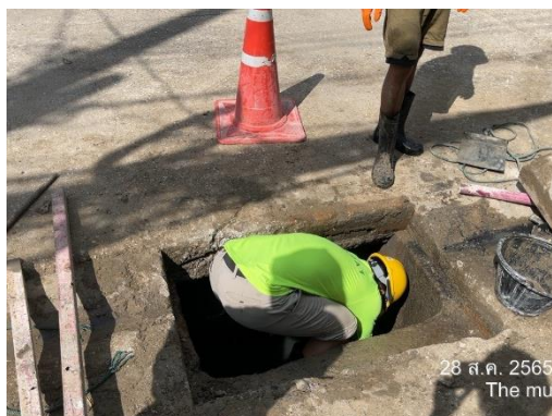
ภาพที่ 2.2-38 การล้างรางระบายน้ำ และบ่อดักตะกอน
