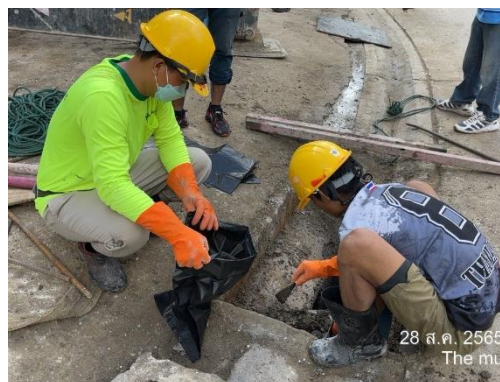
ภาพที่ 2.2-38 การล้างรางระบายน้ำ และบ่อดักตะกอน
