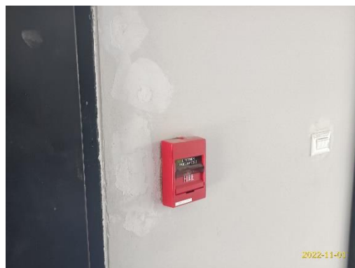
ภาพที่ 2.2-27 ระบบกระจายเสียงอัคคีภัย
