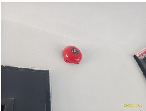
ภาพที่ 2.2-27 ระบบกระจายเสียงอัคคีภัย
