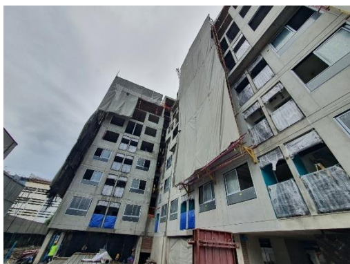
ภาพที่ 2.2-14 ผนังชนิดสำเร็จรูป
